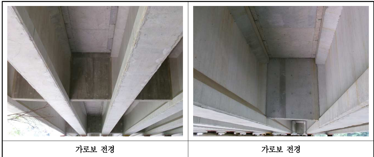
【사진 35.3.6】 가로보 전경
