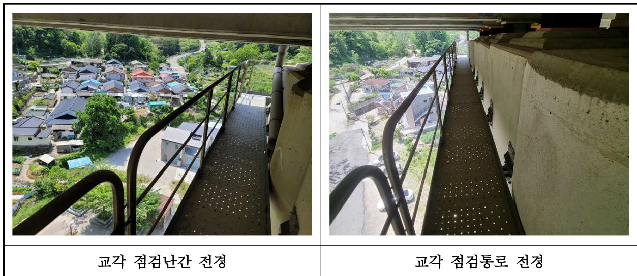
【사진 35.3.26】 교량 점검시설 전경
