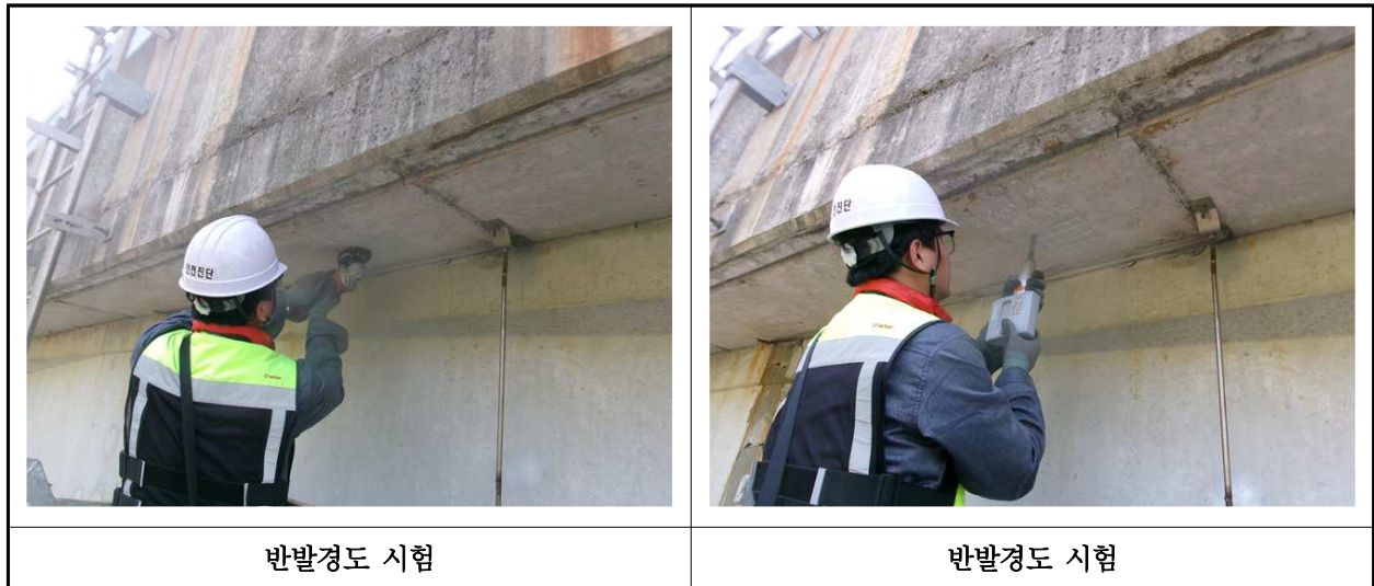
【사진 35.4.2】 반발경도시험 현장사진
