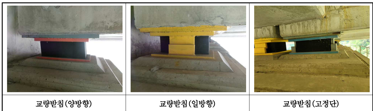
【사진 35.3.13】 교량받침 전경
