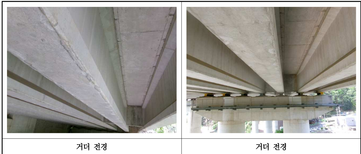
【사진 35.3.4】 거더 전경
