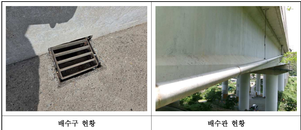
【사진 35.3.22】 배수시설 전경
