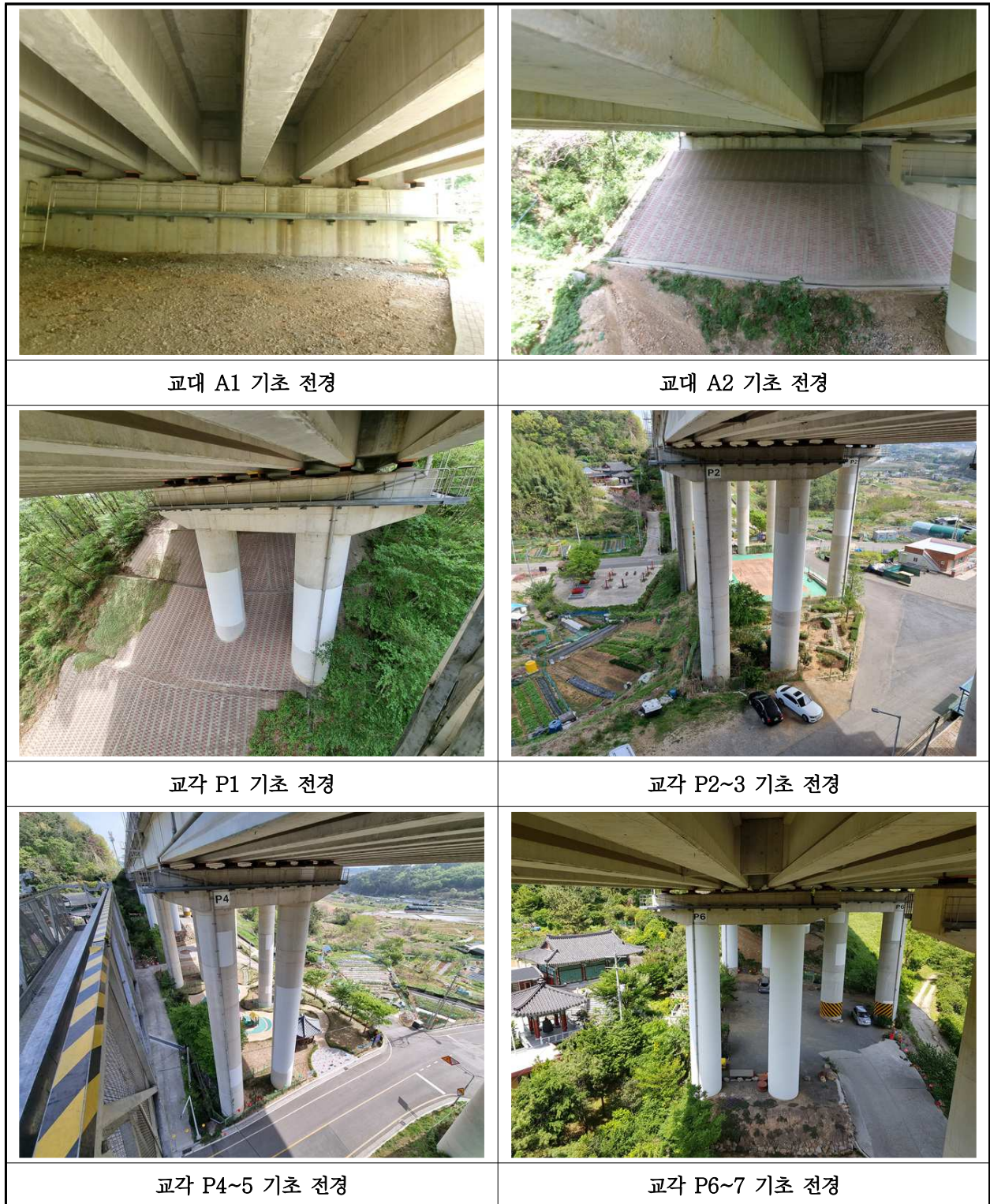
【사진 35.3.12】 기초 전경
