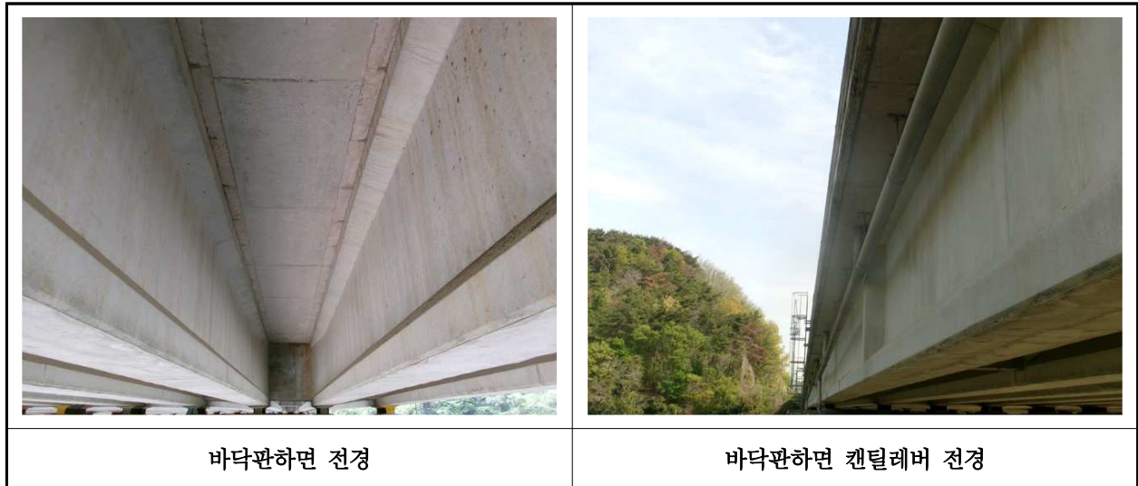
【사진 35.3.2】 바닥판하면 전경
