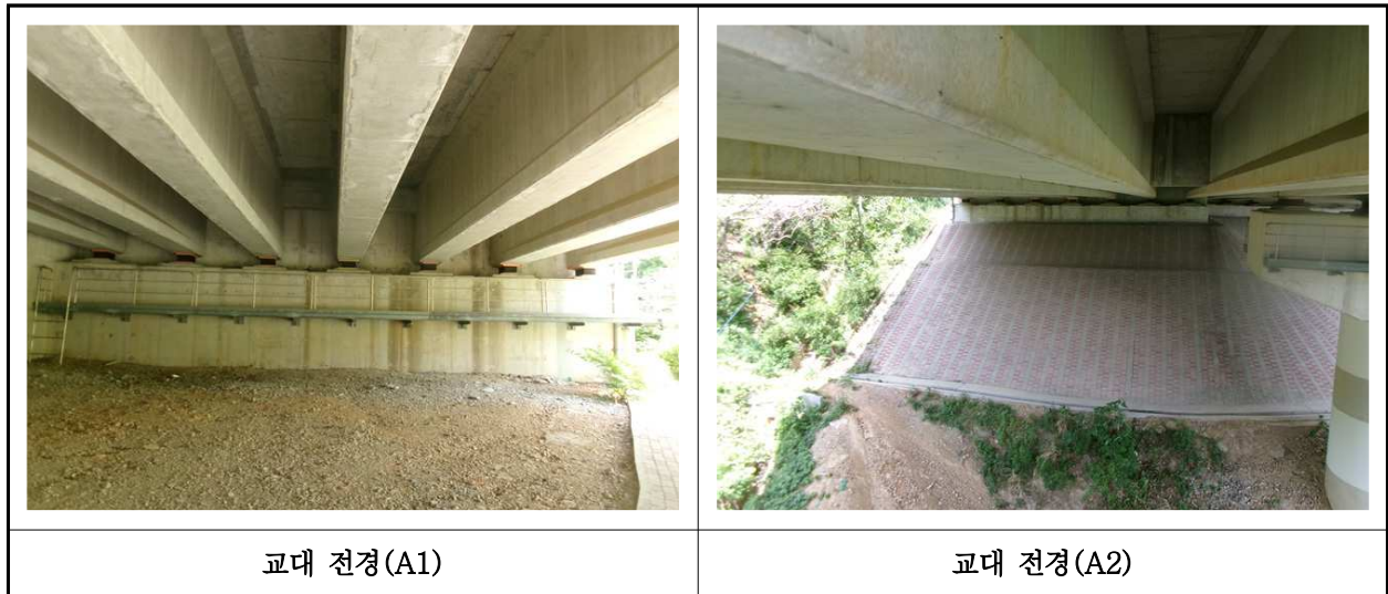
【사진 35.3.8】 교대 전경
