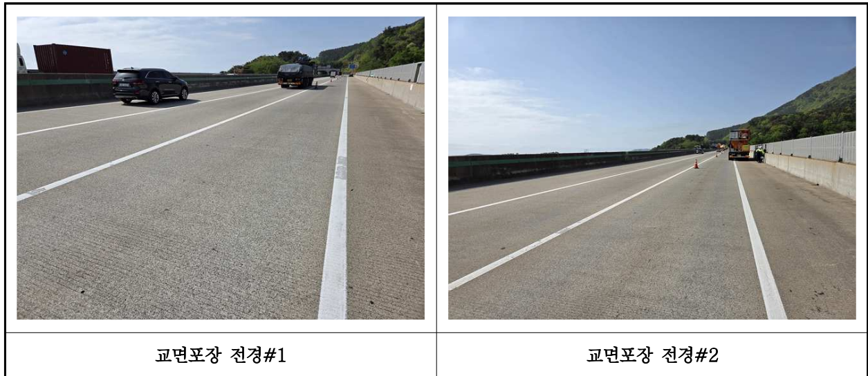
【사진 35.3.20】 교면포장 전경
