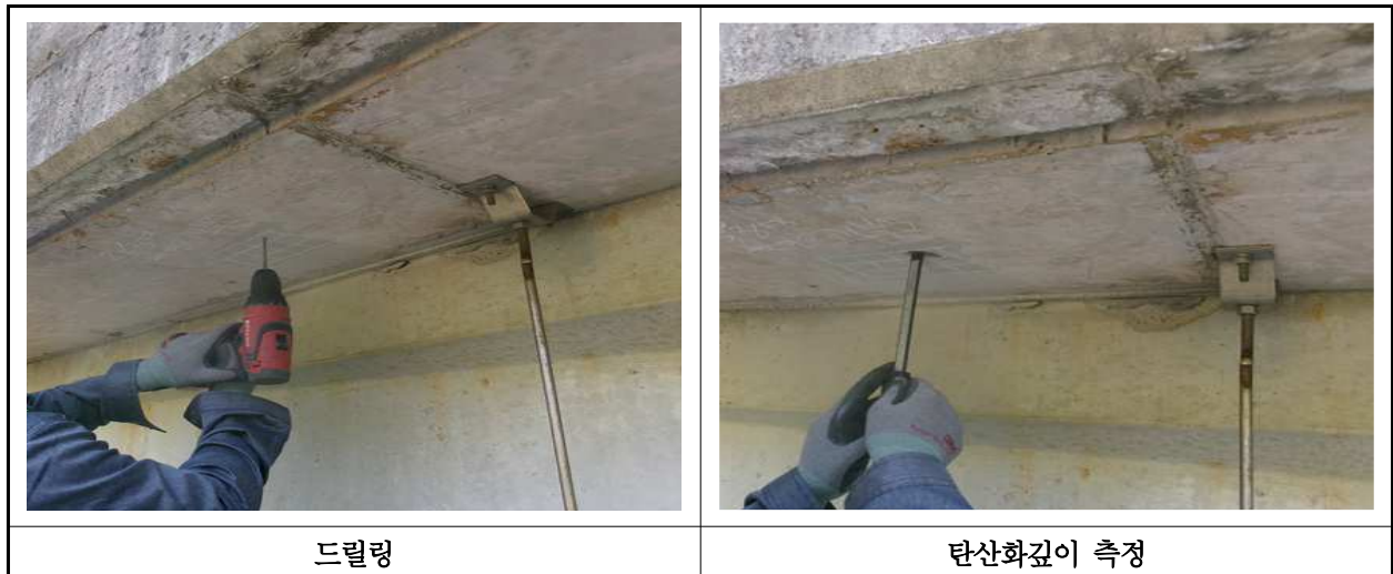
【사진 35.4.3】 탄산화 깊이 측정 현장사진
